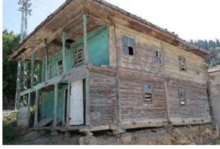
Resim 23. Samsun-Yakakent Kuzuören Köyü Camisi
