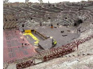
Construction of the stadium «Arena di Verona»
